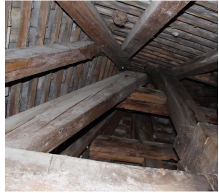
Contrepoids ainsi qu'une partie de la charpente intérieure en bois
