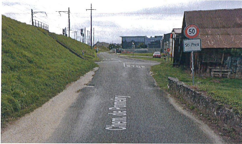
Figure 6 – Aménagement - état actuel à proximité du passage inférieur (PI) Perreret & chemin du Glapin
